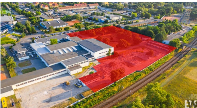
Fot. (powyżej) Teren kompleksu sportowego Zawisza - na czerwono zaznaczono obszar budowy. Powstająca konstrukcja hali (po prawej).
