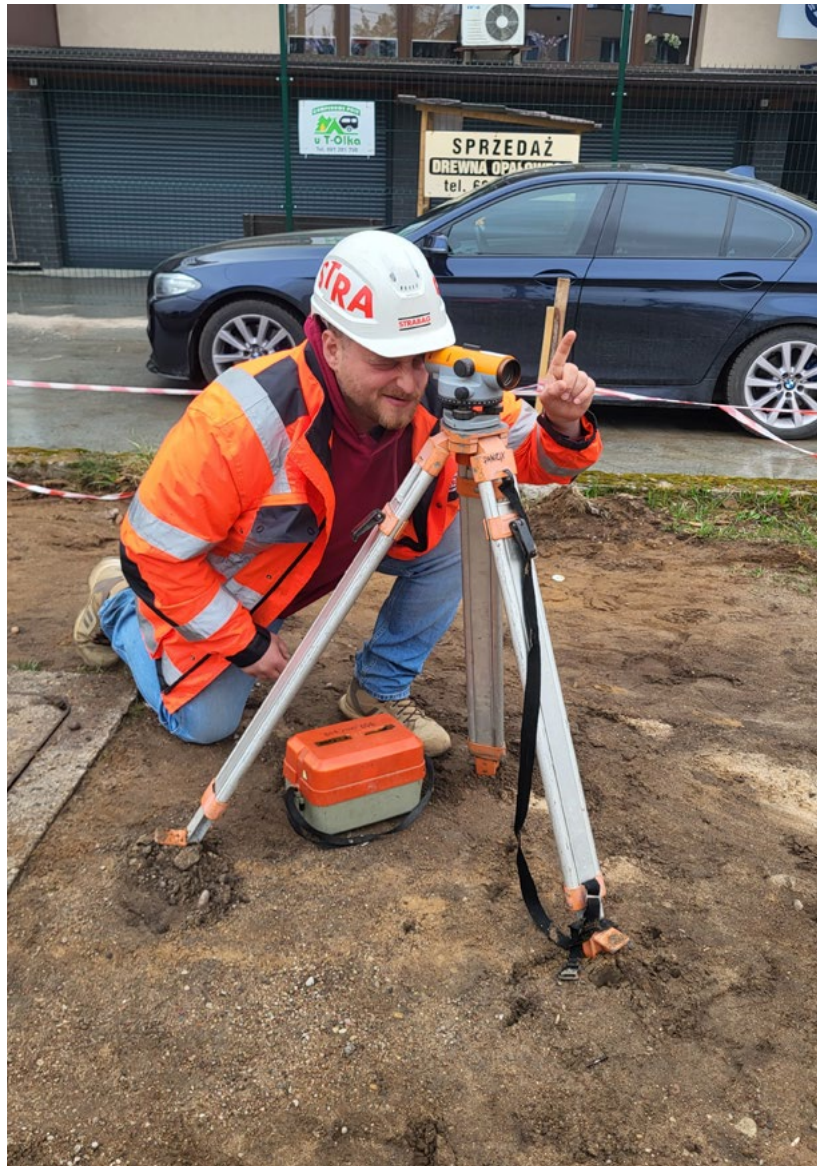
Fot. Antoni podczas wykonywania pomiarów na budowie.
