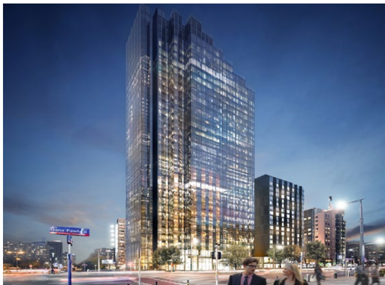
Fot. Budowa autostrady A2 na wschód od Siedlec (góra), wizualizacja Upper One (dół) w Warszawie.
